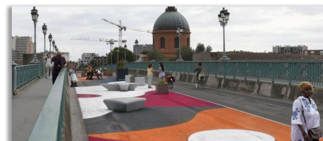
Passerelle existante - Pont Saint Pierre, Toulouse
